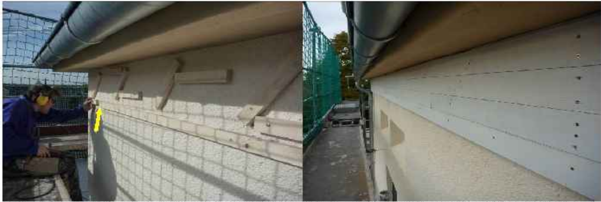
Abbildung: Pulldach. Höhe der Spaltquartiere von 20 cm, entscheidend für die Funktionsfähigkeit ist die Lattenkonstruktion. Der Dachkasten kann auch überlappend mit dem Drempeblech verkleidet werden. Öffnungen sollten in Bereiche gesetzt werden, wo keine Fenster sind.
